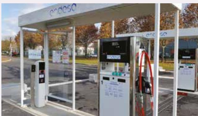
**La plus grande station-service publique française GNV/BioGNV est exploitée par Endesa en Ile-de-France à Bonneuil-sur-Marne.** La station accueille tous types de véhicules, 24h/24, sur une surface de plus de 4 000 m<sup>2</sup>. Elle permet l'avitaillement simultané de 4 véhicules en moins de 15 minutes grâce à 3 conteneurs comprenant chacun un compresseur de 660 Nm<sup>3</sup>/h.
