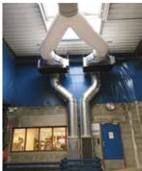
Les gaines d'air froid assurent une diffusion régulière dans l'ensemble du volume d'exploitation en 15-25.
