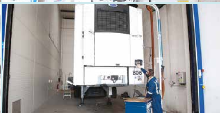
Cinq travées sont équipées de lignes de vie qui empêchent les chutes éventuelles.
