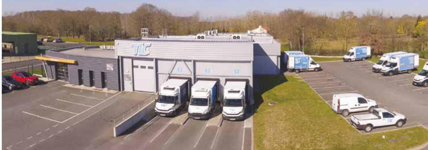
Plateforme frigo proche du nouveau M.I.N. de Nantes de 1 000 m 2 en +2°C/+4°C et une chambre de 100 m 3 en surgelé avec 2 quais PL et 7 VUL.
