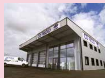
Le nouveau centre SAV de CD Froid a pour objectif l'amélioration du service et une productivité accrue.
