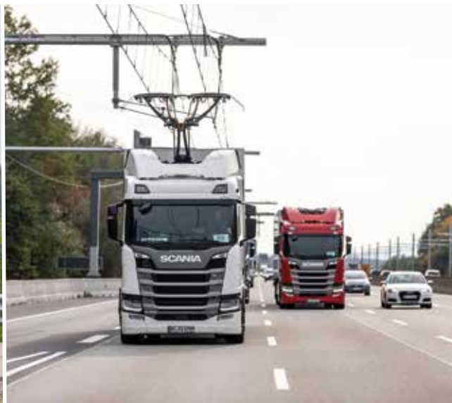
Route électrique avec caténares testée en Allemagne.
