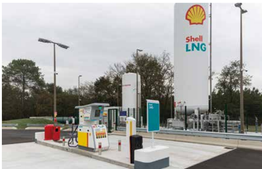
La station de Cestas Est complète la couverture pour le réseau GNL au sein de l'axe entre Paris et Bordeaux.
