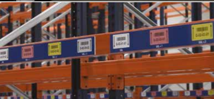
Les plateformes logistiques sont qualifiées selon la norme FDX 15.140 de même que la totalité du parc roulant.
