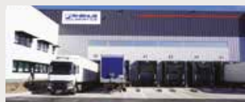
Nouvel entrepôt Rhenus à Cestas (Gironde).
