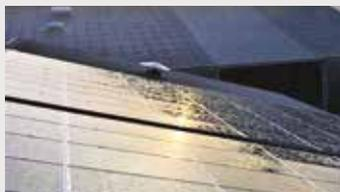
*En ruisselant sur le champ photovoltaïque, l'eau de pluie refroidit et nettoie les modules.*
