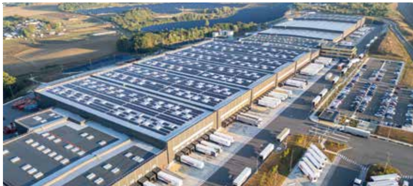
Base logistique mixte - multi-températures à Roulet-Saint-Estèphe.
