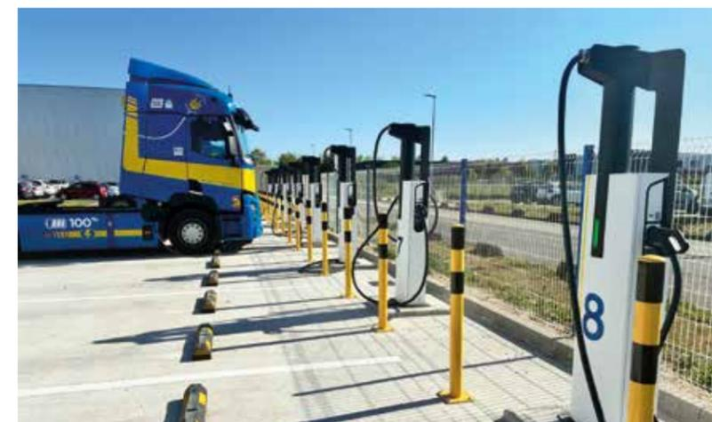
Les deux stations de 200 kW exploitées par Chargepol assureront aux véhicules de passer de 15 à 80 % d'autonomie en 1h30.
