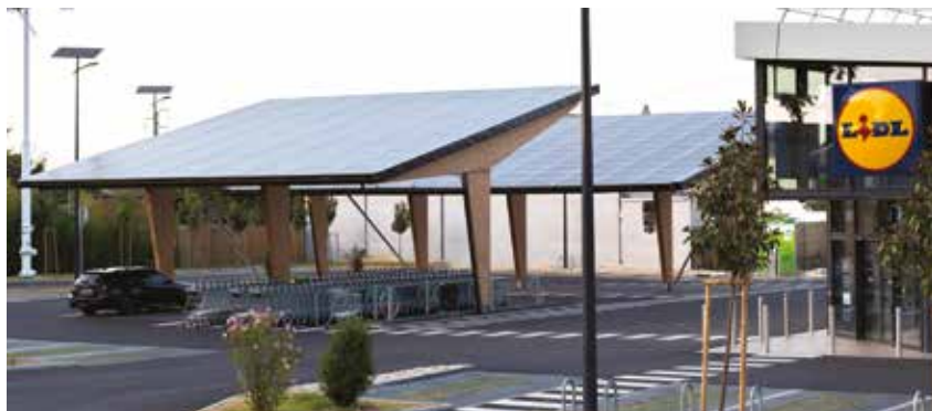
En 2023, LIDL disposera de 500 000 m 2 de panneaux photovoltaïques installés sur les toitures et les ombrières de ses parkings pour atteindre l'autonomie électrique, voire devenir producteur d'électricité.
