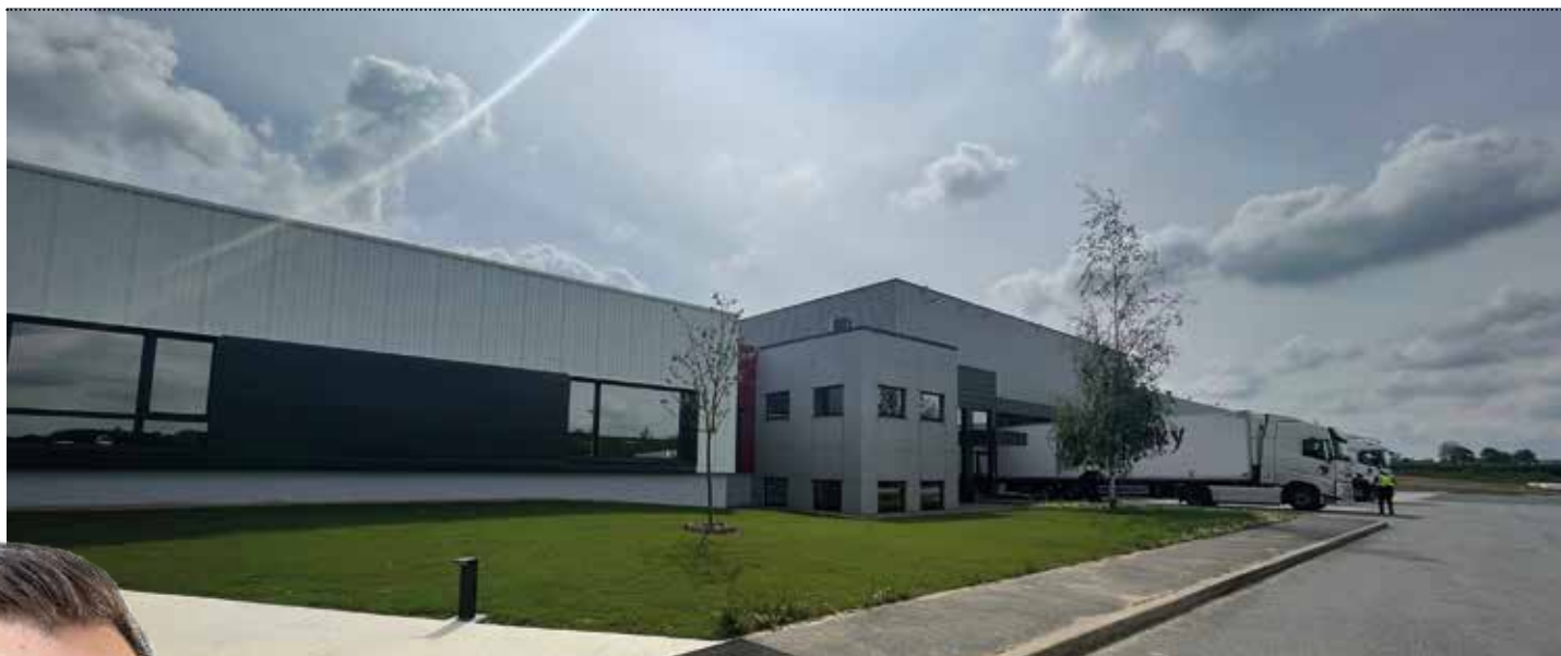
Inauguré en 2010, le site breton de Saint-Onen-la-Chapelle (35) bénéficie cette année d'une extension de 2 000 mètres carrés dotés de 300 m² de panneaux solaires.
