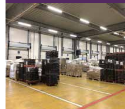
La plateforme logistique de STEF au Plessis-Pâté s'étend sur 12 000 m 2 et compte 26 portes à quai.
