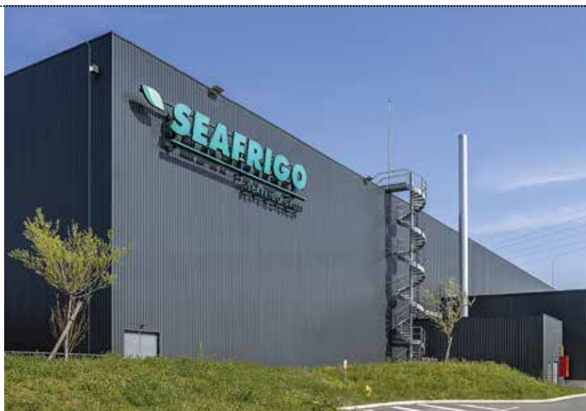
Les bâtiments situés dans le port du Havre sont loués à Seafrigo dans le cadre d'un bail jusqu'à fin 2033.
